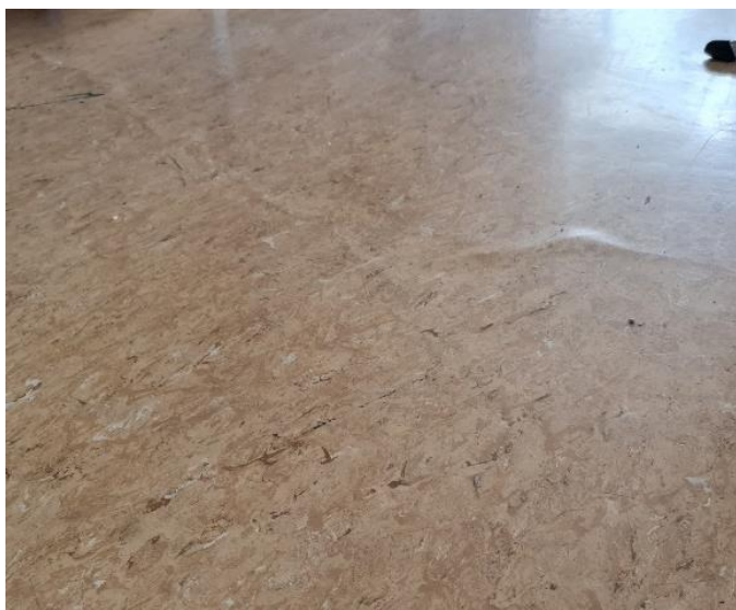
Mynd 2. Ummerki um raka undir gólfdukk
