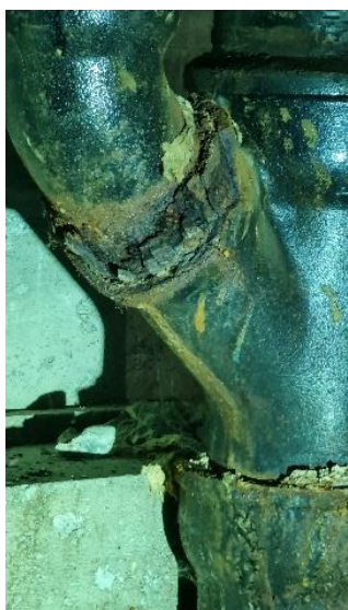
Mynd 1. Skólprör í slæmu ásigkomulagi
