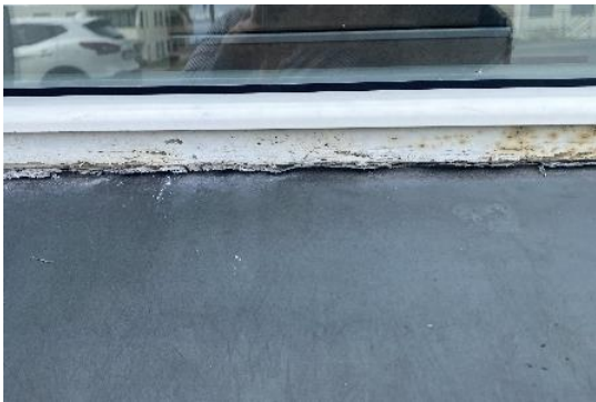
MYND 9 Gluggaþéttingum er víða ábótavant
