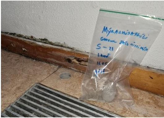
MYND 7 Sýni tekið í tengibyggingu á 1. hæð
