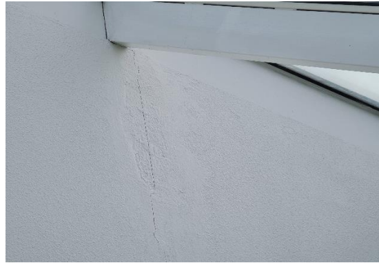
MYND 8 Gömul rakaskemmd undir þakglugga
